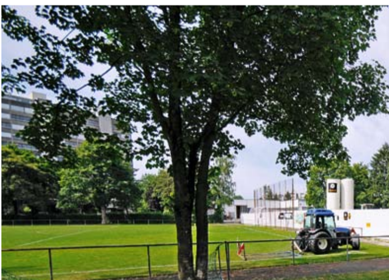
Versuchsbaugrube im Juni 2009. Fouille d'essai au mois de juin 2009.
